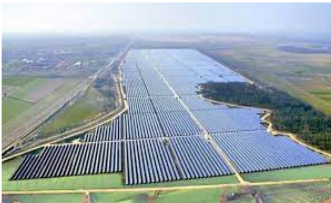
USINA SÃO GONÇALO, MAIOR USINA SOLAR DA AMERICA LATINA – OBRA TOZZI LATAM DO BRASIL
